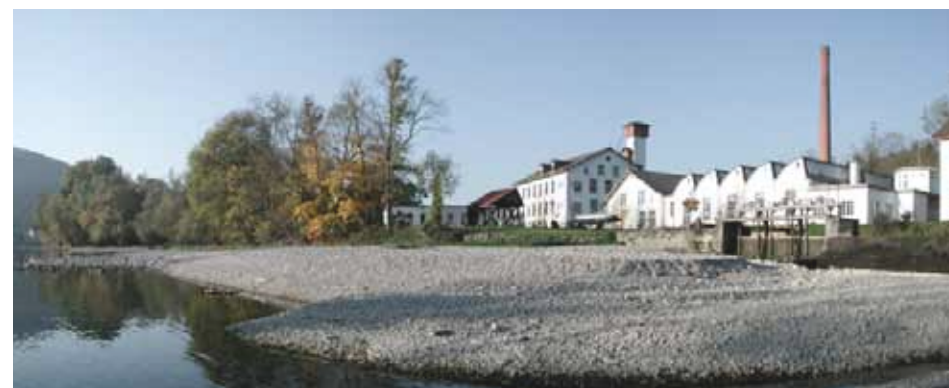
Das Fabrikareal «Stroppe» am Zusammenfluss von Limmat, Reuss und Aare.
